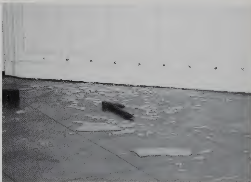
Vue partielle de l'installation.
