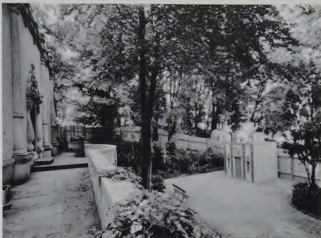
Vue depuis le balcon du 1 er étage du pavillon russe.
